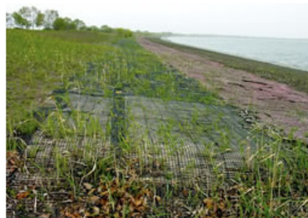
トリカルネット施工例(河川敷の葎おさえ)
