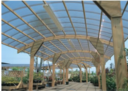
ポリカミイタ施工例(屋根)
